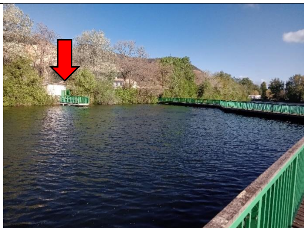
St-pomp - Station de pompage pour la cimenterie LAFARGE – vue depuis la passerelle piétonne
