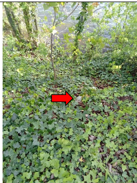
8- Station de relevage EU – canalisation de rejet vers le lac en cas de débordement du poste – Angle Sud-ouest du lac
