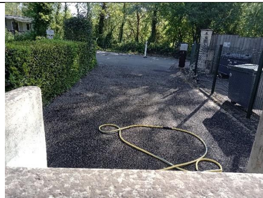
C – Harmony Camping – zone de vidange camping-car (raccordée au réseau collectif)
