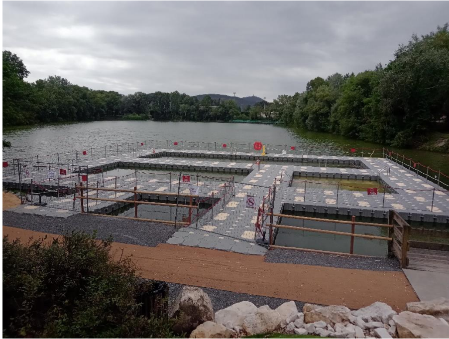
Figure 31 : structure flottante à Cruas – saison 2024
