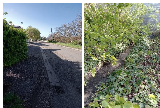
REJET – rejet eaux pluviales dans le lac angle Sud-Ouest proche du rejet du poste EU
