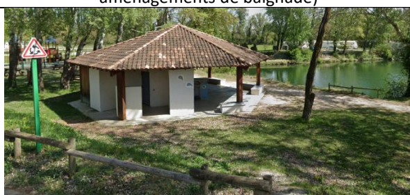
3- Toilettes / WC public
