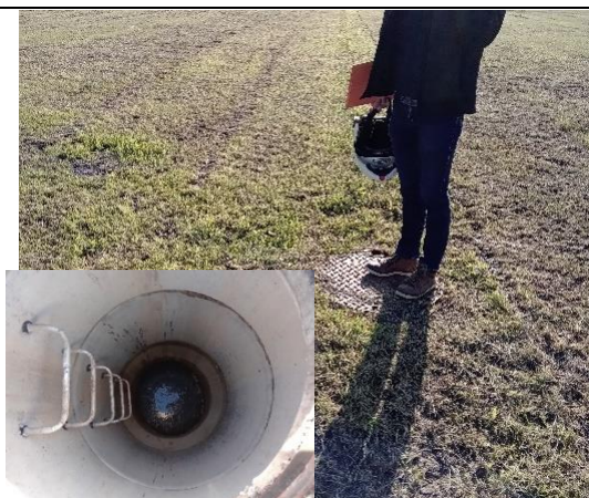
Réseau des eaux pluviales en amont Nord du lac (future site de la piscine municipale)
