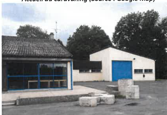
Ancienne base nautique, sanitaires de la plage (Source : IRH IC)
