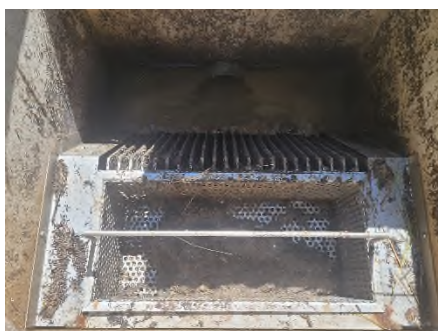
Vue sur le dégrilleur
