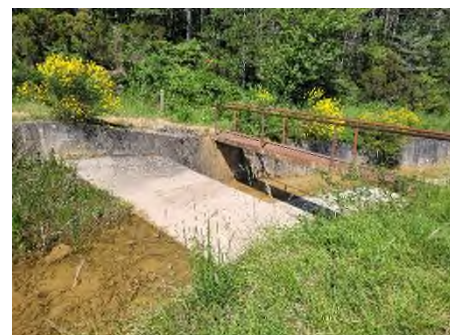
Vue sur l'ouvrage de surverse
