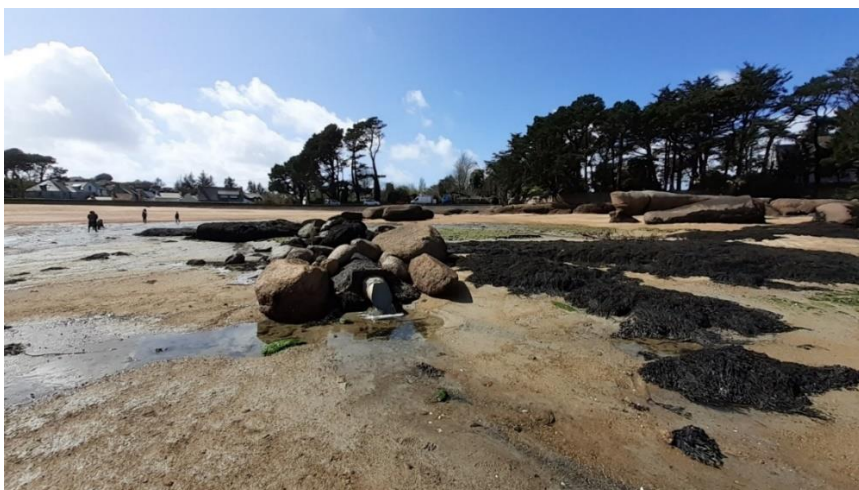
Figure 35 : Photos de l'exutoire pluvial situé à l'Ouest de l'estran. Source LTC 2024
