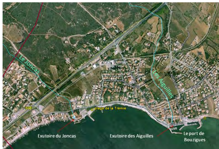
Figure 47 : vue aérienne des exutoires hydrographiques à proximité de la zone de baignade de la Trémie (Google Earth, BD Carthage, ARS)
