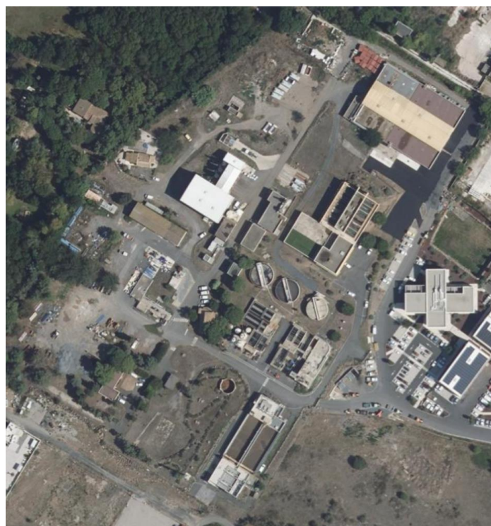
Figure 31 Vue aérienne de la STEP (Source : Géoportail)
