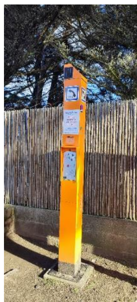
Téléphone de secours
