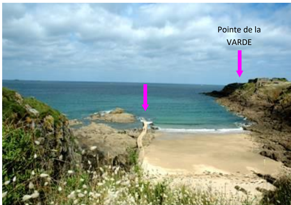
Point de rejet de l'émissaire pluvial de la VARDE
