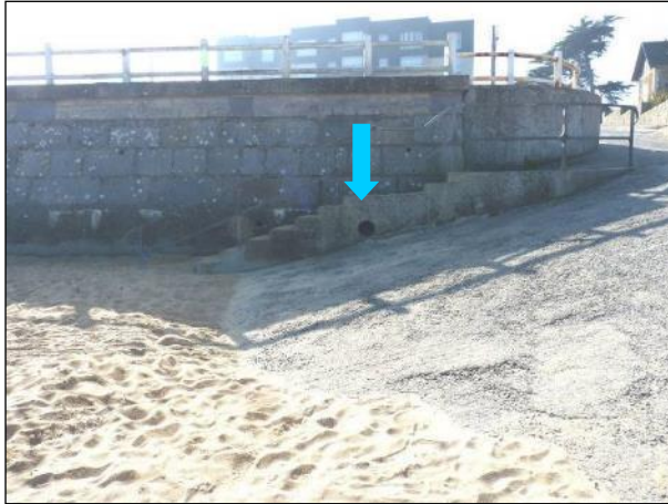
Exutoire pluvial situé au niveau de la rampe d'accès
