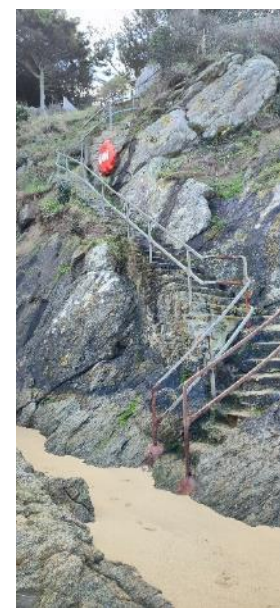
Escalier d'accès à la plage
