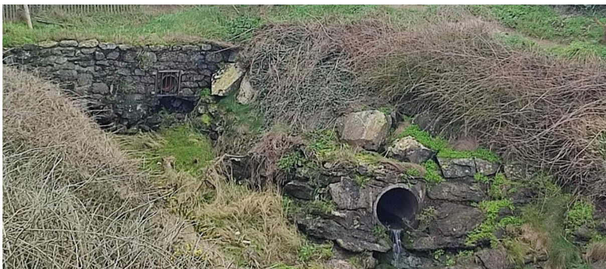
Figure 26 : Exutoires pluviaux au droit du parc du NICET
