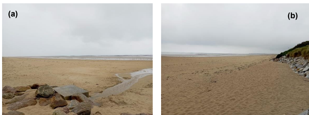
Figure 2 : Plage de Denneville – Vues prises de la cale d'accès le 22 mai 2024 Vue au sud – (b) Vue au nord
