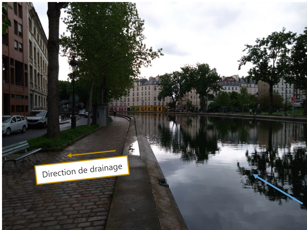
Figure 27 : Détails des berges du bassin des Récollets ; partie aval (a) et partie amont (b).
