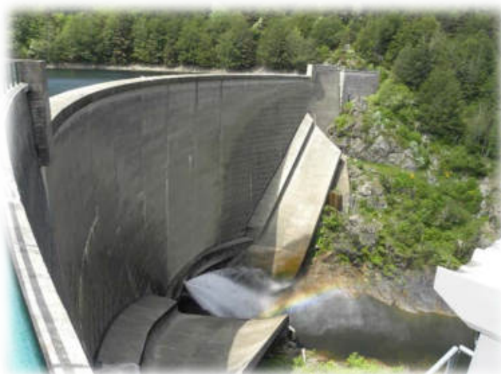
Barrage de La Palisse (cliché IATE de juin 2016)
