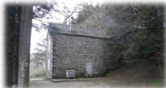
Ancienne maison de la pisciculture (cliché du 22/04/2021)
