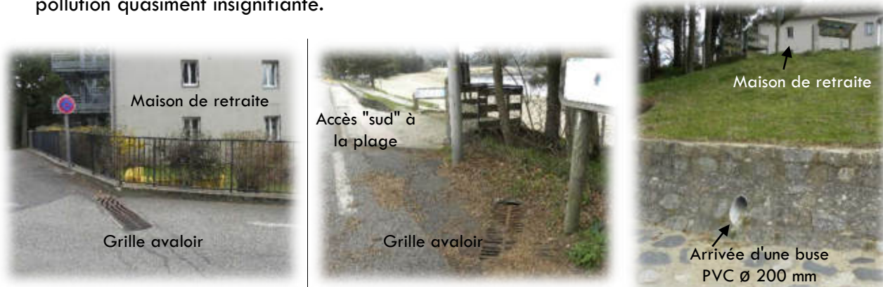
Grilles avaloirs et buse collectant une partie des eaux d'un tronçon de la RD 116 (clichés du 22/04/2021)
