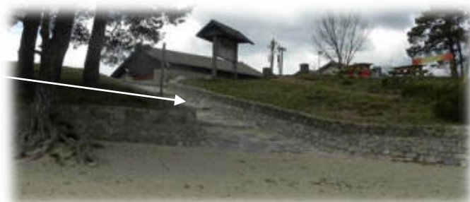
Accès à la plage surveillée côté "nord"
