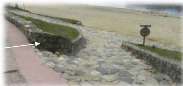
Les deux accès "sud" à la plage (Clichés du 22/04/2021)
