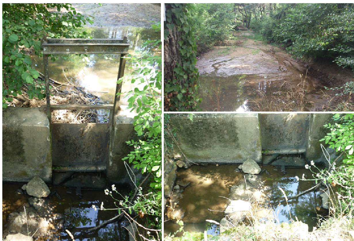
Figure 27 : Ruisseau des Pêcheurs et seuil (Source : ATHOS Environnement)
