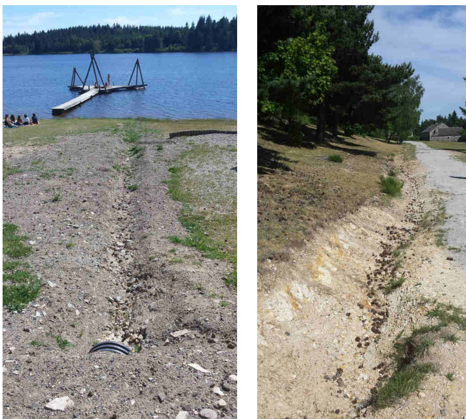
Figure 42 : Photographies des rigoles de drainage sur la base de loisirs et ses accès (Source : ATHOS Environnement 2015)
