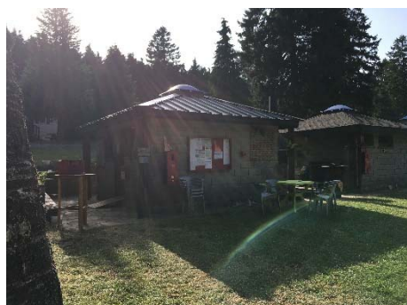
Vue sur le poste de secours situé au niveau de l'accueil du camping
