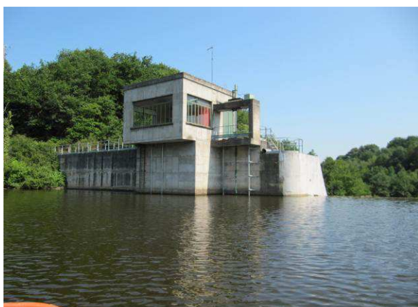
g. Point de prélèvement pour l'alimentation en eau potable.
