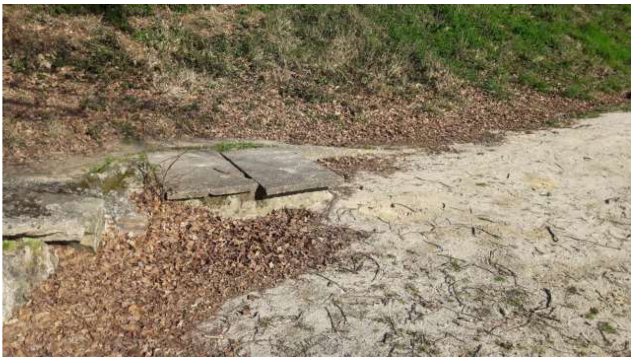
Fig. 16 : Regard de visite de l'exutoire pluvial visible dans l'angle Nord-Est de la plage du Rond-Point
