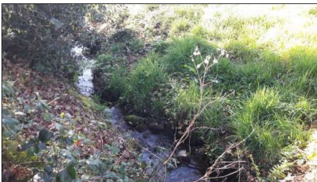
Fig. 14 : Prise de vue du fossé en aval de la RD18
