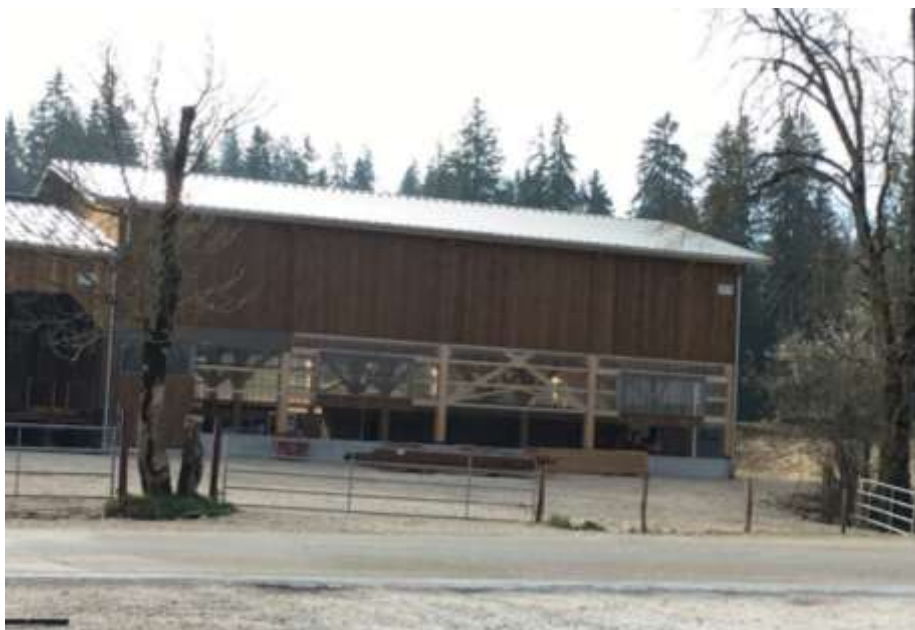
Figure 14 : Résultat des travaux réalisés sur la ferme Ferreux à l'ancien emplacement du tas de fumier en plein air. Une fosse couverte a été créée.
