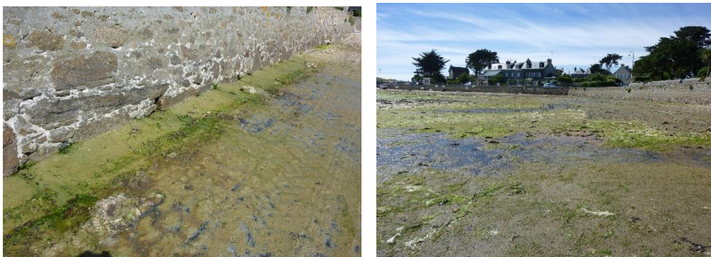
Figure 28 : Zones de résurgence le long du mur du port d'Argenton (photographies prises le 07/07/2010)
