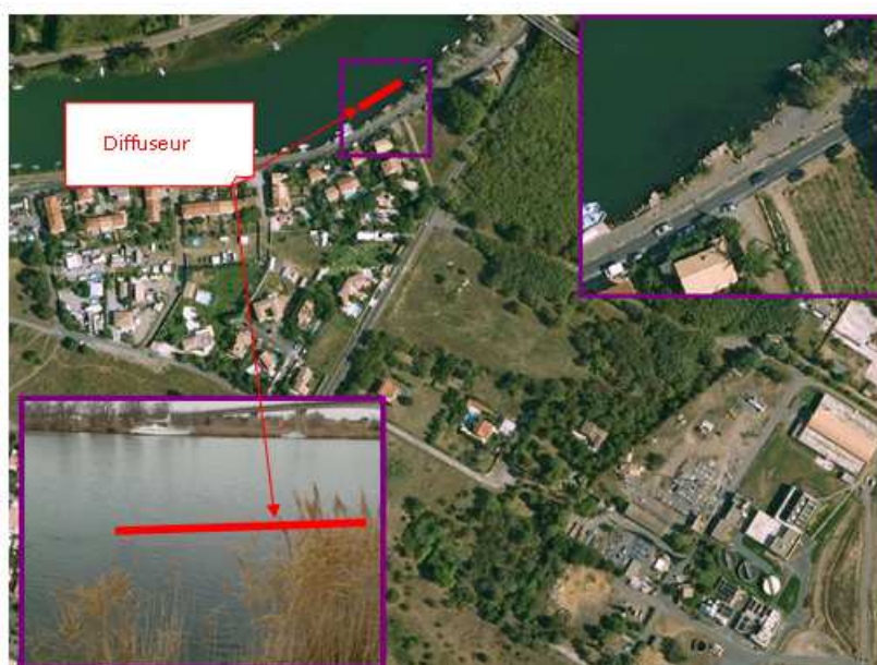
Figure 38 : vue aérienne du point de rejet de la station d'épuration d'Agde (source : Google Maps©, 2010)
