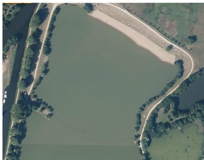
Figure 39 : barrage flottant mis en place entre la pointe et la berge opposée
