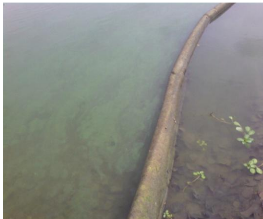
Figure 38: Effets de rétention du barrage
