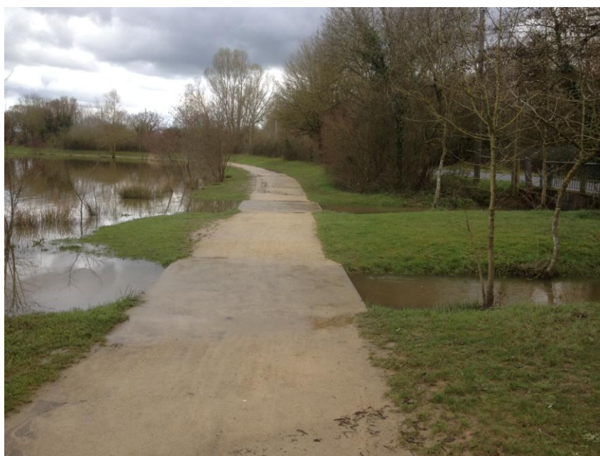
Figure 7 : Exutoire sud de l'étang d'Apigné vers l'étang des Bougrières
