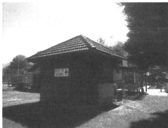
Figure 14 : Vue sur le poste de secours
