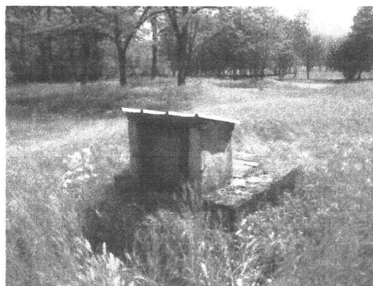
Figure 2 : Point de pompage pour l'alimentation du lac du Marandan par l'eau de la nappe
