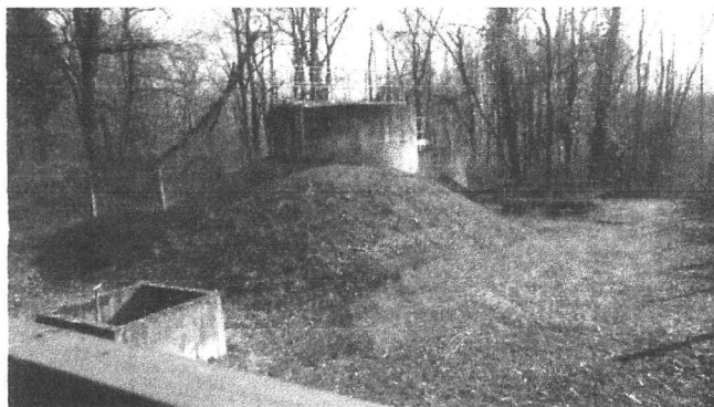
Figure 6 : Station d'épuration de la base de loisirs
