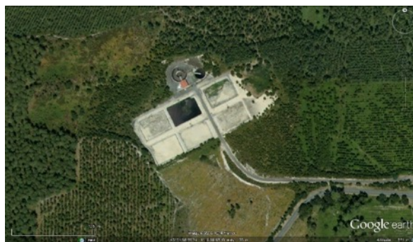
Photographie 4 : Point d'infiltration
