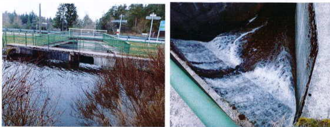
Figure 23 : Evacuateur de crue du plan d'eau (Source : ATHOS Environnement, 2012).
