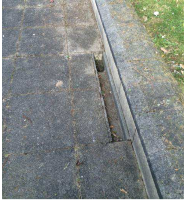
Figure 12 : évacuation des eaux de pluies aux abords du bâtiment principal vers le ruisseau
