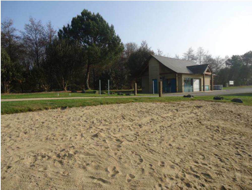
Figure 29 : Poste de secours
