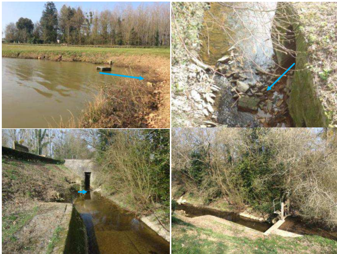
Figure 9 : Moine et ouvrage hydraulique
