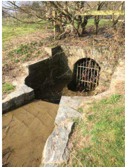
Figure 10 : ouvrage de surverse
