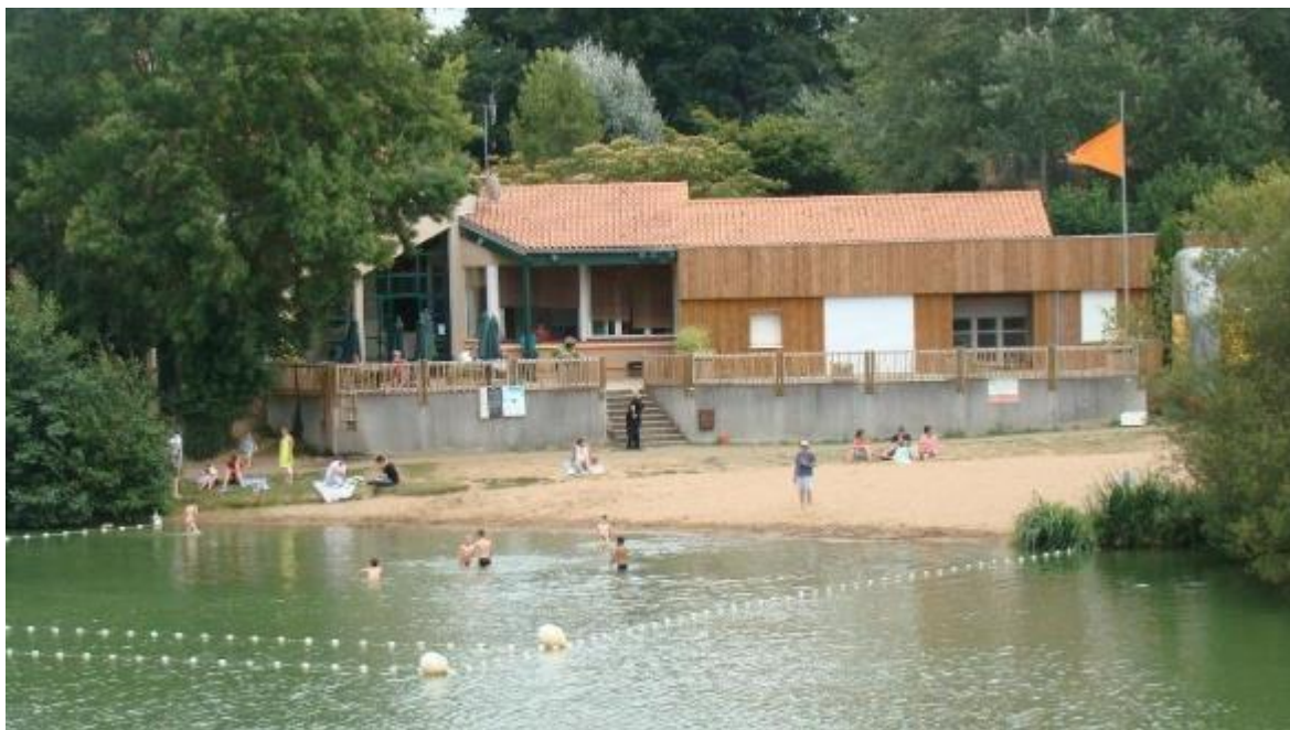
Figure 25 : Bar-restaurant + sanitaires + poubelles à côté de la zone de baignade (Source : https://www.clubcampings.com/france/pays-de-la-loire/camping-coulvee )
