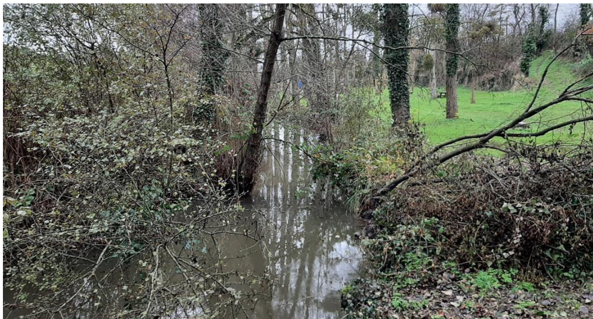
Figure 43 : Arrivée de l'Hyrôme dans le barrage de Coulvée (source : IRH, 12/2023)
