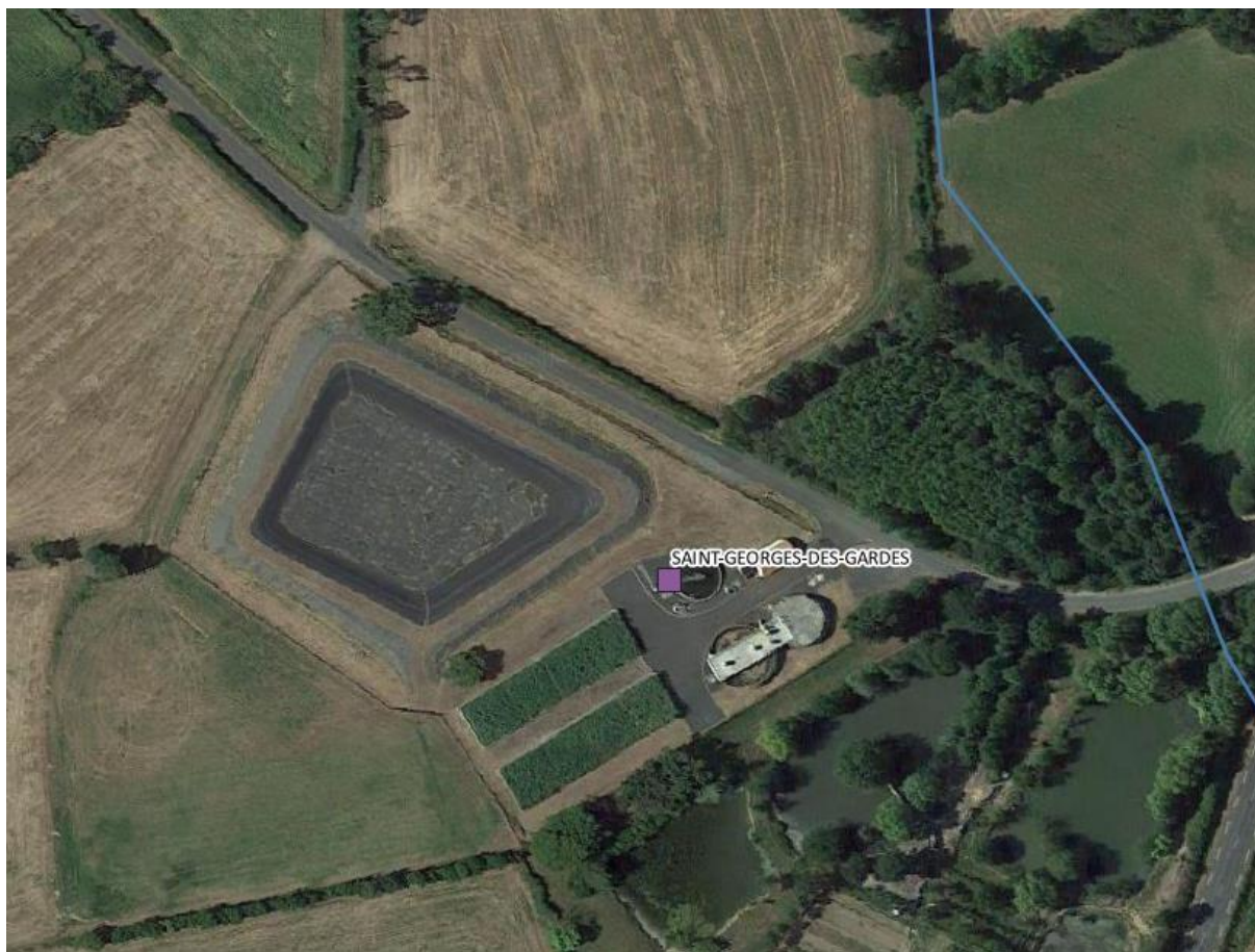
Figure 38 : Vue aérienne de la station de traitement des eaux usées de St Georges des Gardes
