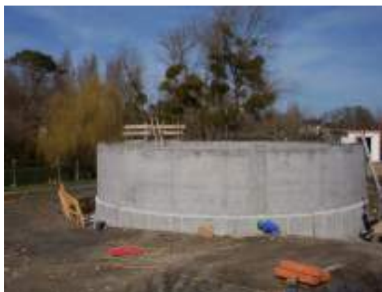
Figure 76a et b : Construction du poste de Mallouet et de sa bache de sécurisation à GRANVILLE – Construction de la bache de sécurisation du poste de refoulement de Laffont à SAINT-PAIR SUR MER – Cliché SMAAG
