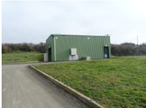
Figure 75 : Construction du poste de Scissy et de sa bache de sécurisation à ST-PAIR/MER – Cliché SMAAG
