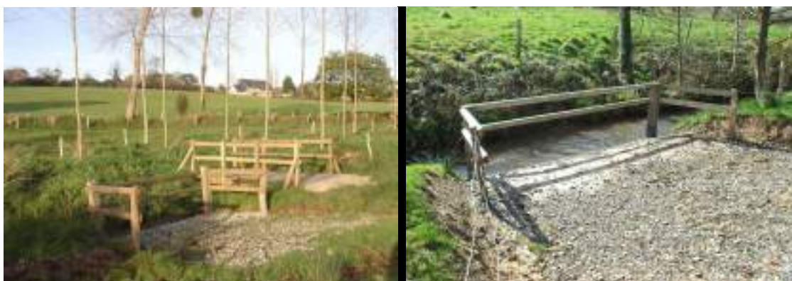
Figure 78 : clichés de travaux de restauration des cours d'eaux.
