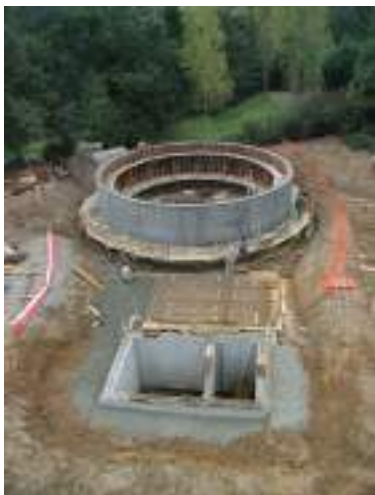
Figure 76a et b : Construction du poste de Mallouet et de sa bache de sécurisation à GRANVILLE – Construction de la bache de sécurisation du poste de refoulement de Laffont à SAINT-PAIR SUR MER – Cliché SMAAG
