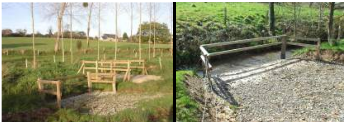
Figure 75 : clichés de travaux de restauration des cours d'eaux.
