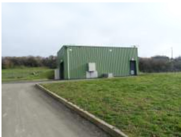
Figure 74: Construction du poste de Scissy et de sa bache de sécurisation à ST-PAIR/MER – Cliché SMAAG
