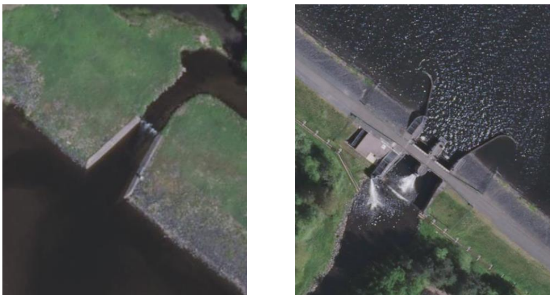
Figure 9 : Photographies aérienne de la vanne d'alimentation (à gauche) et du barrage (à droite) du lac de la Plaine (Géoportail, 2018)
