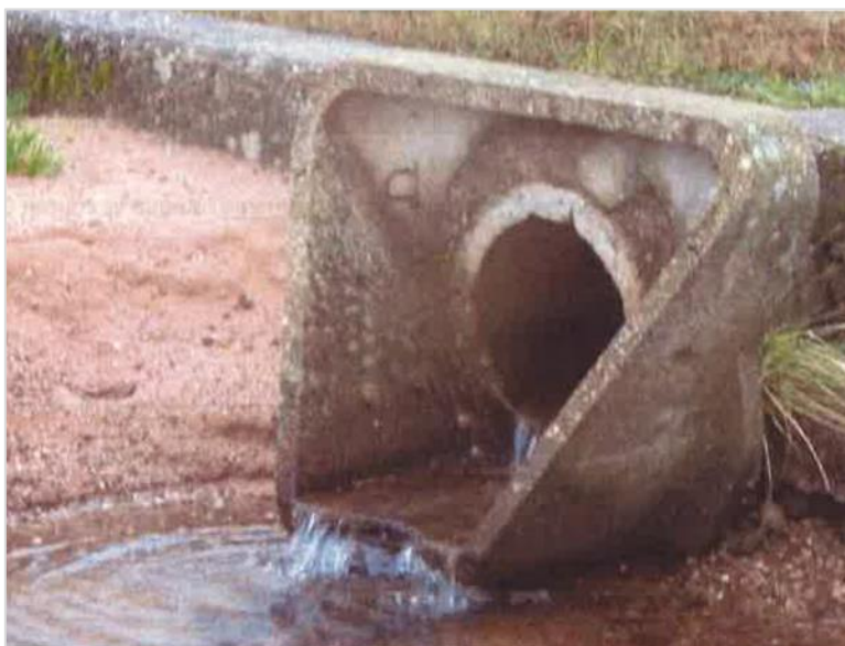
Figure 53 : Exutoire pluvial situé sur la plage
