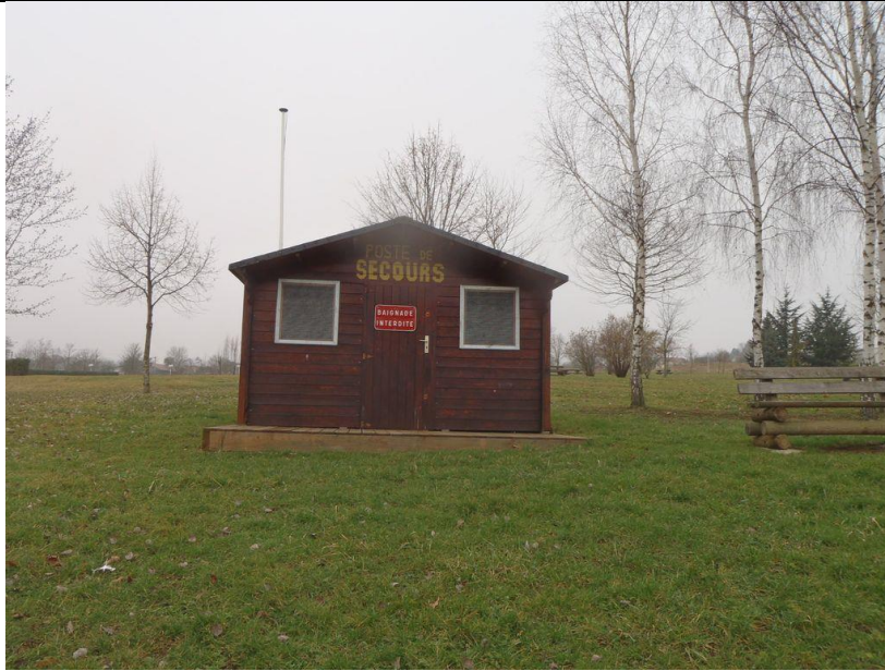
Figure 22: poste de secours
