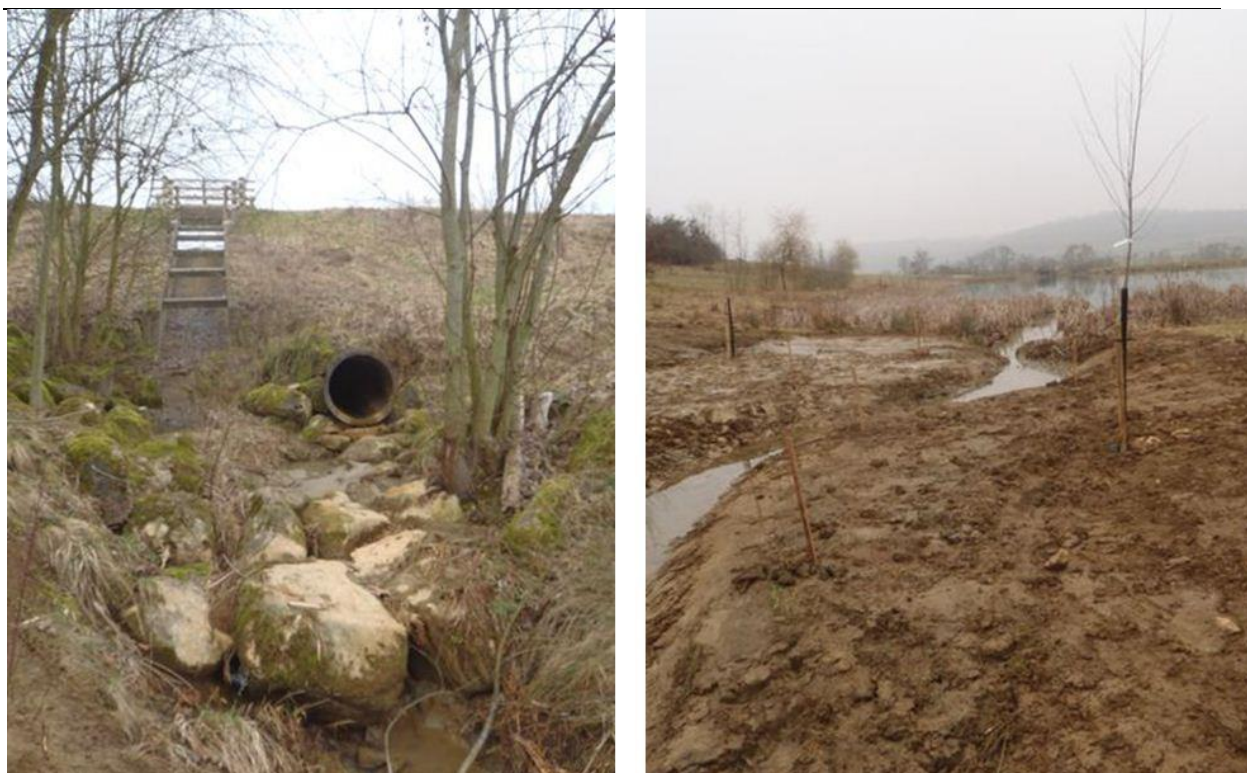
Figure 11: reméandrage en cours entre les deux étangs
