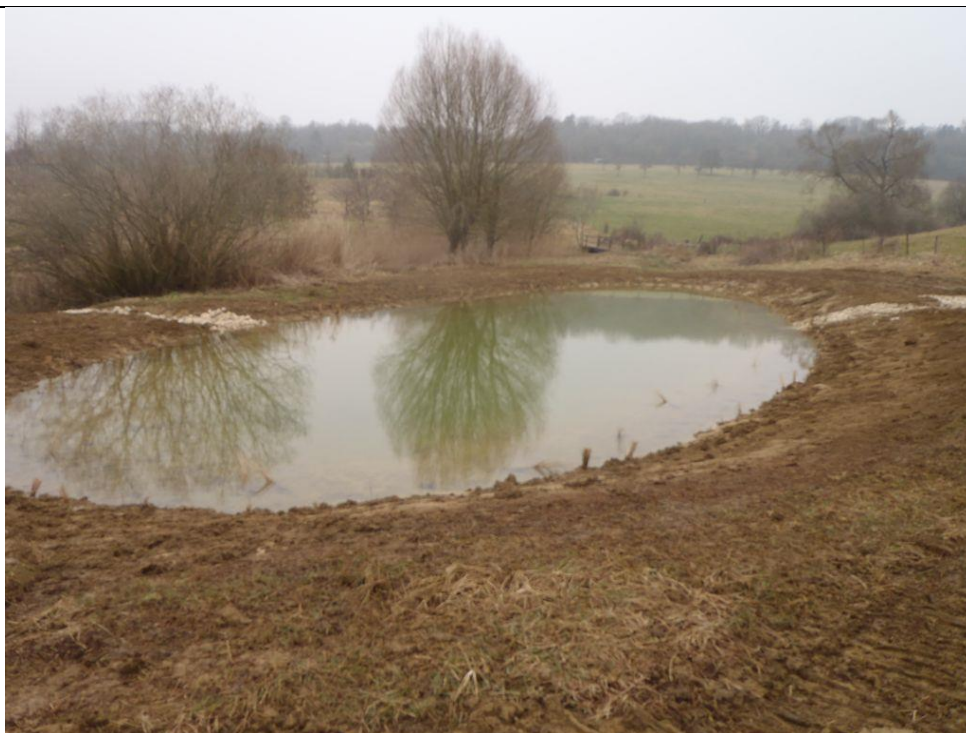
Figure 9: mise en place de la mare écologique
