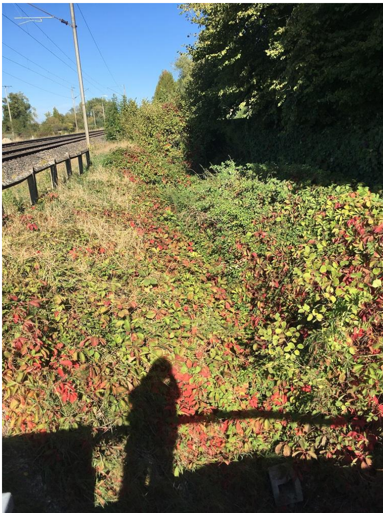
Figure 46 : fossé de la voie ferrée (tronçon aval) juste en amont du busage final (photographie Génie de l'eau 17 septembre 2019, prise depuis le passage à niveau)
