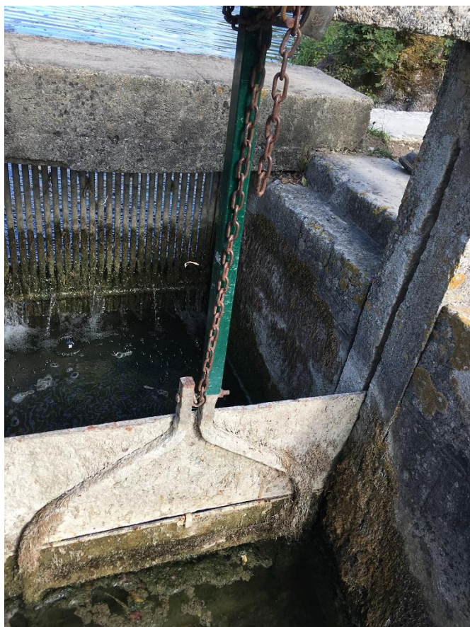
Figure 6 : vanne de sortie de la Ballastière (photographie Génie de l'eau 17/09/2019)
