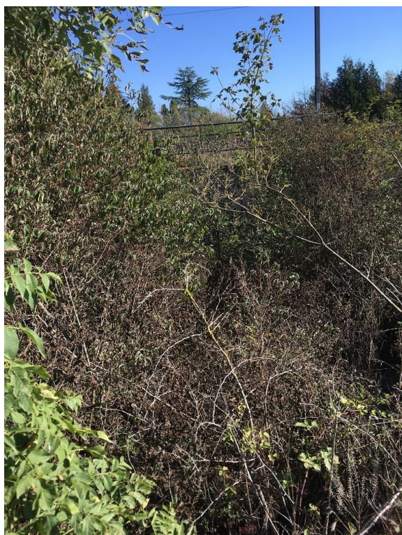
Figure 48 : petite traversée sous la voie ferrée au niveau de la zone de stockage de matériel (tronçon aval) (photographie Génie de l'eau 17septembre 2019)
