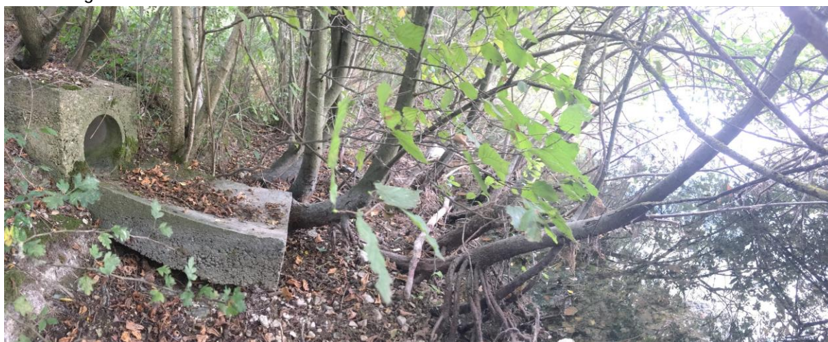
Figure 4 : exutoire du fossé SNCF sur les berges de la Ballastière
