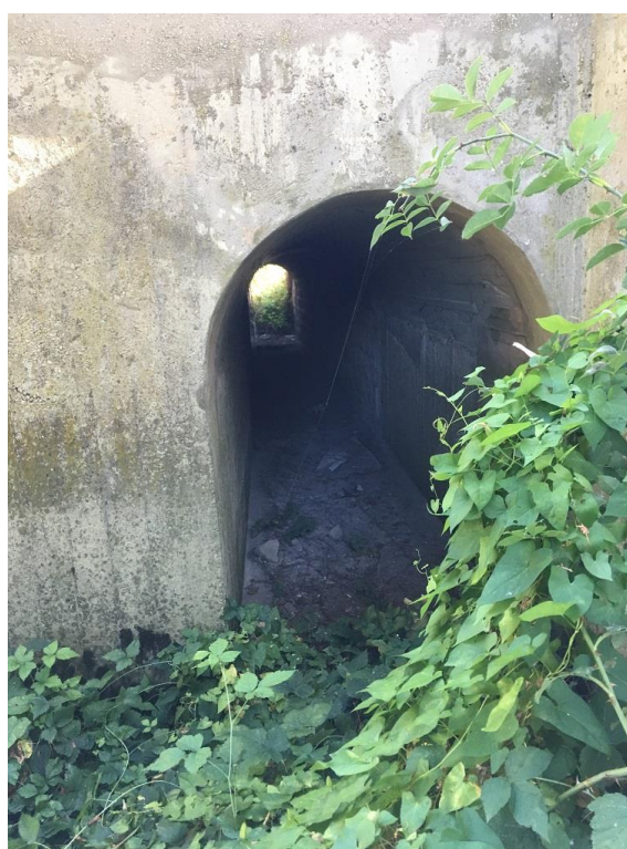
Figure 49 : traversée principale sous la voie ferrée au niveau de l'exploitation agricole (tronçon amont) (photographie Génie de l'eau 17septembre 2019)
