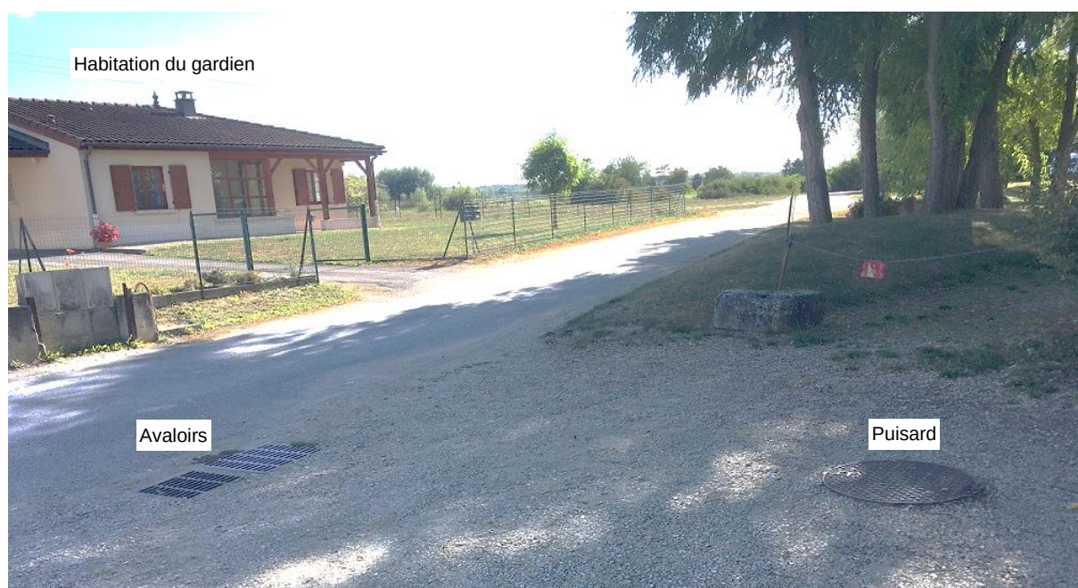
Figure 41 : photographie de l'avaloir à l'extrémité de la voirie d'accès à la Ballastière (Génie de l'eau, 17/09/2019)
