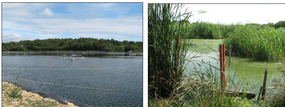
Figure n°30 : Bassin d'aération et bassin à macrophytes de la STEP de Kerran
