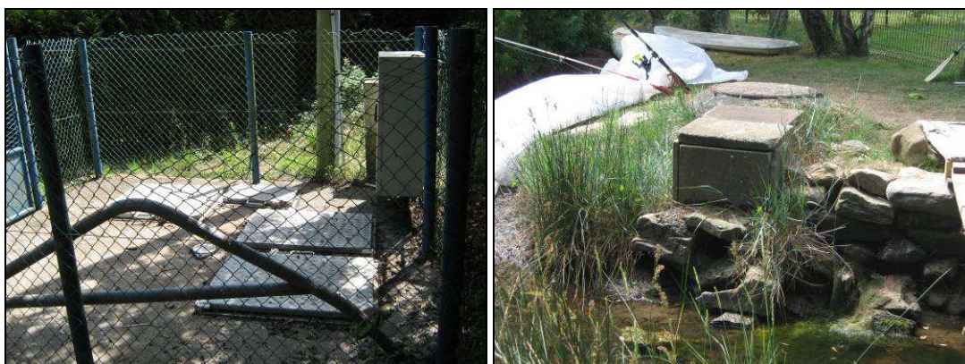
Figure n°34 : Poste de relèvement de Men-er-Beleg et son rejet de trop-plein
