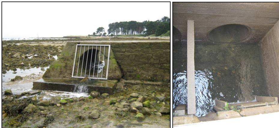
Figure n°40 : Exutoire principal (à gauche) et vannes à marée (à droite) du bassin versant de Men-er-Beleg
