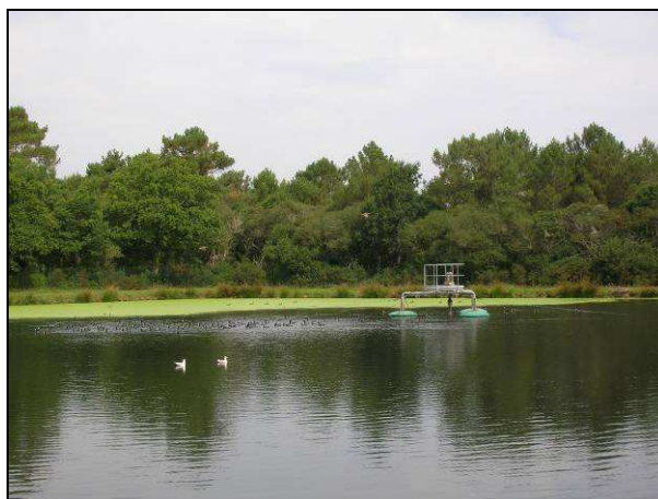
Figure 44 : Bassin de lagunage de Manester
