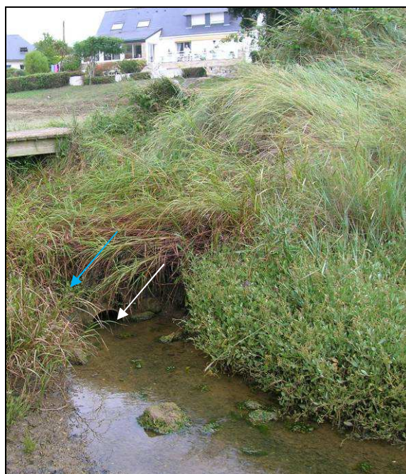
Figure 53 : Rejets de l'anse de Mané-Vechen – Secteur Nohic (Flèche bleue : rejet aval du bassin –fossé enherbé et flèche blanche : rejet busé )
