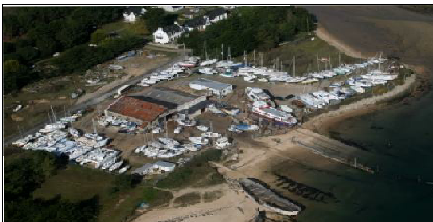
Figure 15 : Chantier du Magouër
