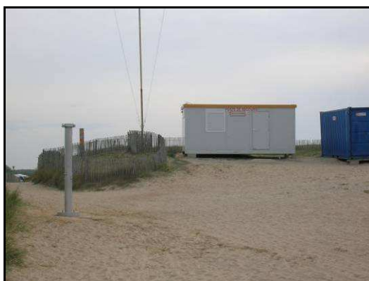
Figure 19 : Poste de secours et douche du Magouëro
