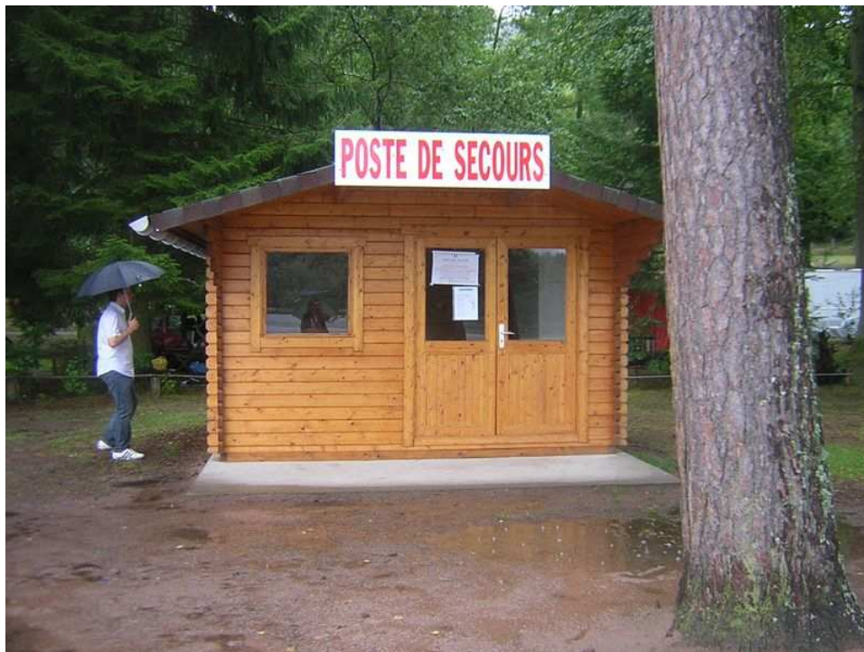
Figure 13: poste de secours
