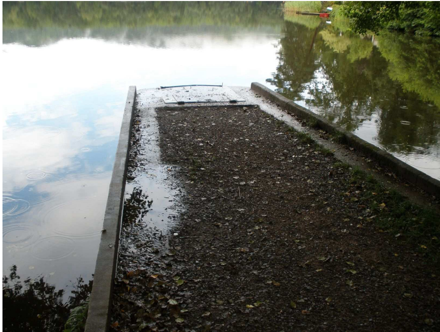
Figure 7: moine: système de vidange de l'étang
