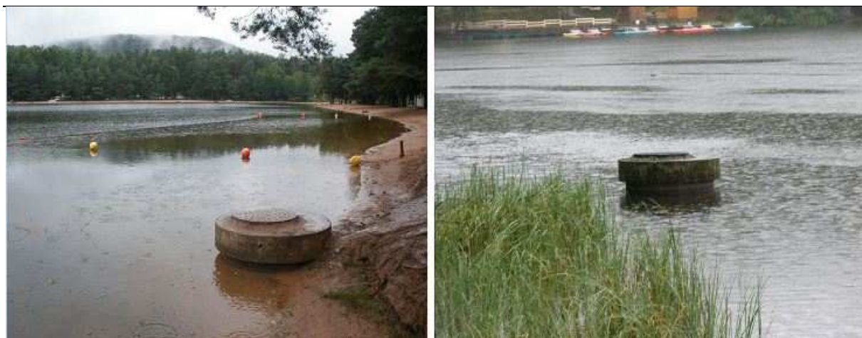
Figure 31: regards issus du réseau d'assainissement du camping
