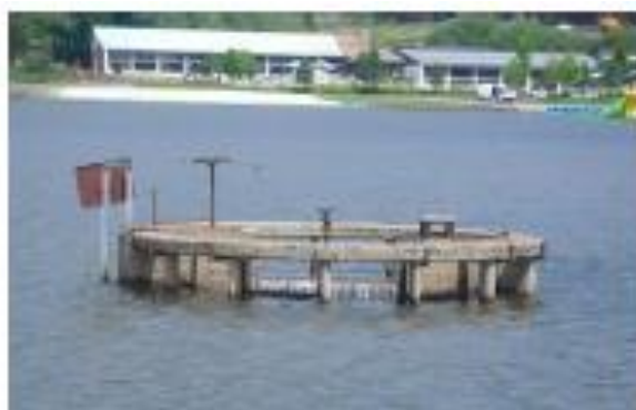
Figure 28: Évacuateur de crue du plan d'eau (Source : ATHOS Environnement, 2012)
