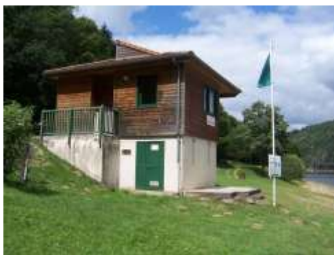
Figure 2 : Photographie du poste de secours, mât et panneau d'information sur le site de Pont du Bouchet
