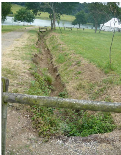
Illustration 22 : Fossé longeant les installations du site de baignade (Crédit photo : Géonat)
