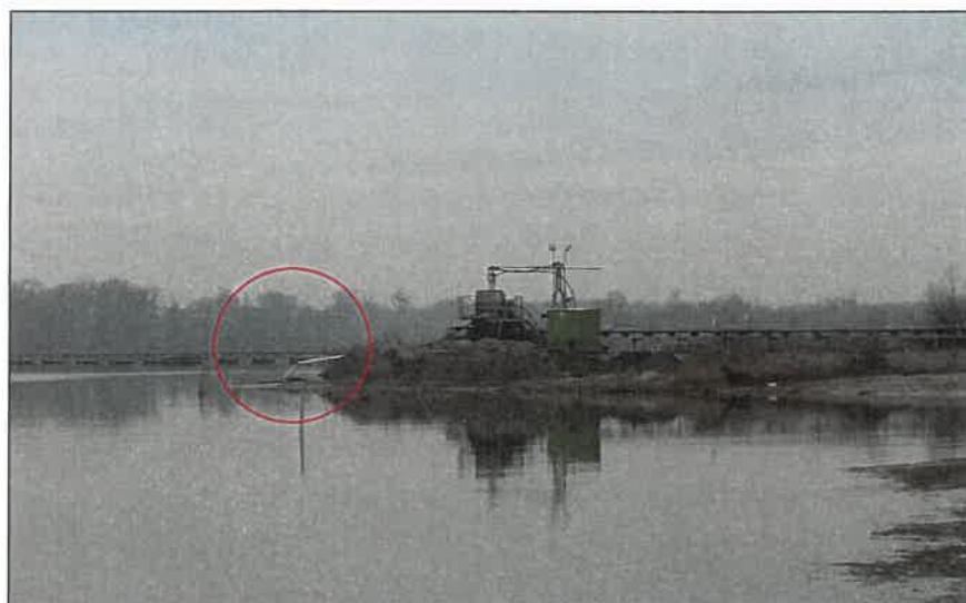
Figure 24: rejet des eaux de lavage et présence de la drague à proximité de la plage
