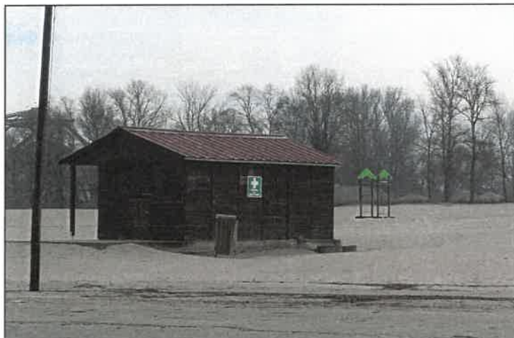
Figure 12: poste de secours
