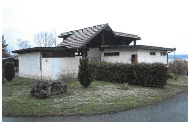
Figure 19 : bloc sanitaire –Secteur Sud
