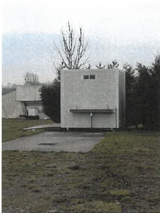
Figure 18 : bloc sanitaire - secteur central
