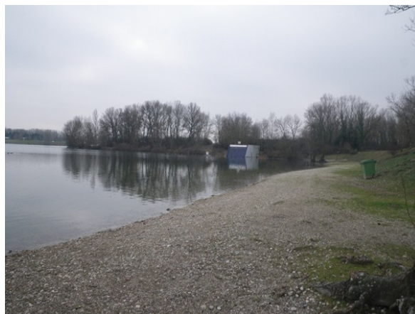
Illustration 4: le captage des Eaux Bleues vu depuis la plage de la Baraka
