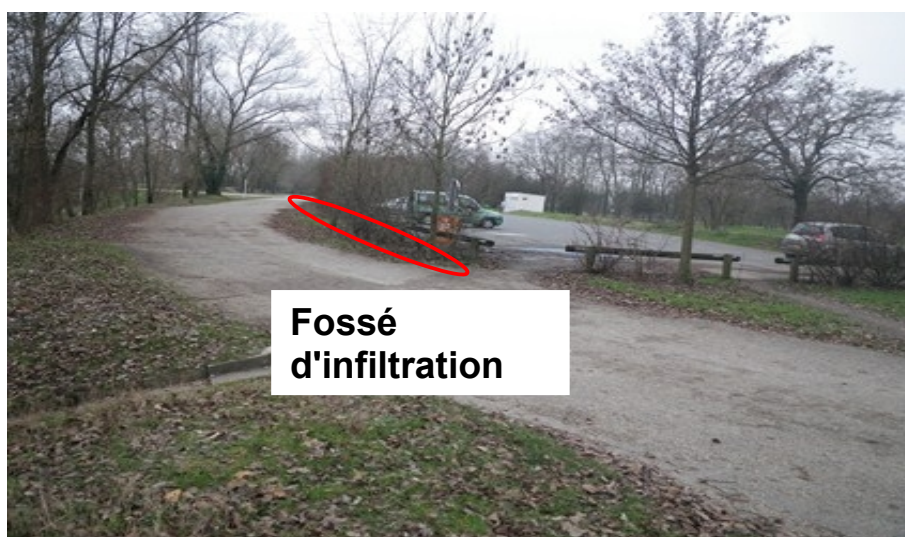
Illustration 30: Parking de la Baraka : fossé d'infiltration
