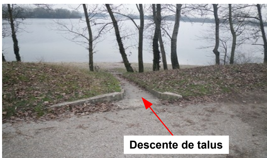
Illustration 31: Parking de la Baraka : descente de talus
