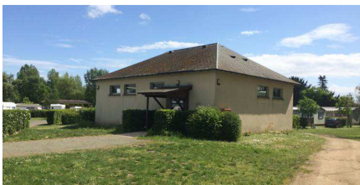
Figure 28 : Bloc sanitaire du camping
