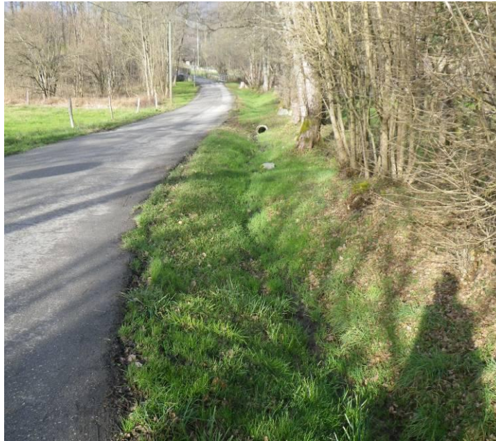
Figure 31 : Fossé de collecte des eaux pluviales le long de la route menant au camping (Source : photo CIDEE)
