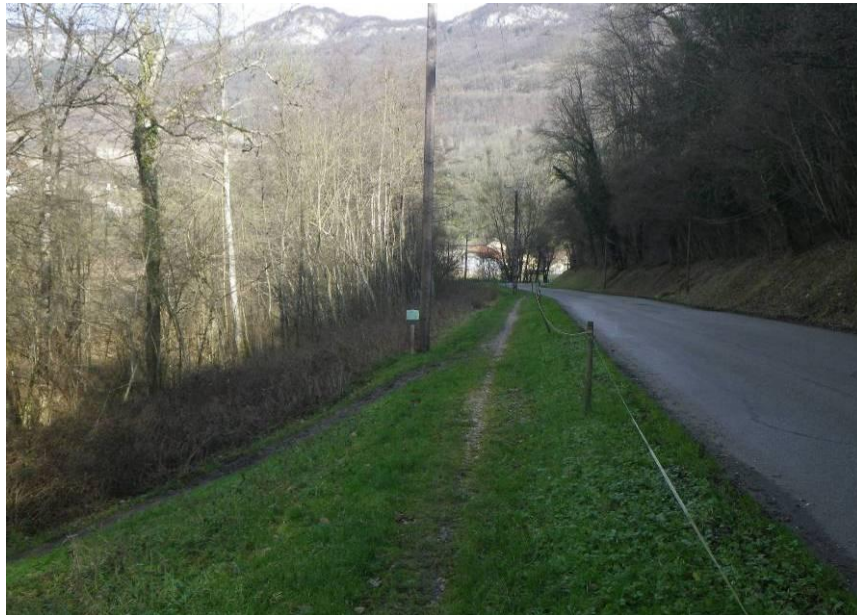
Figure 32 : RD210e non équipée de réseau de collecte des eaux pluviales, rive est du lac (Source : photo CIDEE)
