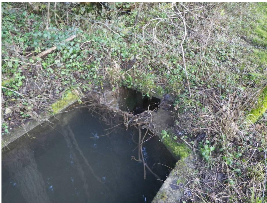
Figure 26 : Ouvrage d'entonnement des eaux d'exhaure du tunnel du Chat
