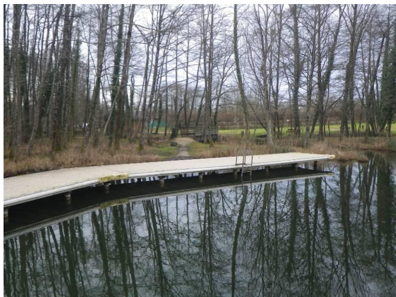
Figure 16 : Vue de la rive Sud depuis les pontons (source : photo CIDEE)
