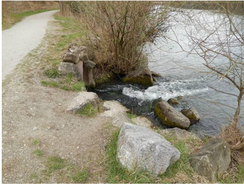
Figure 10 : Rejet du canal de Pau dans le lac
