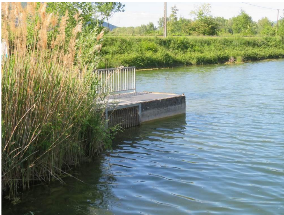
Ouvrage de régulation au niveau de l'exutoire du plan d'eau
