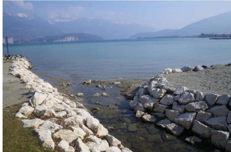
Figure 23 : Exutoire du ruisseau de la Combe dans le lac d'Annecy (08/03/2011)
