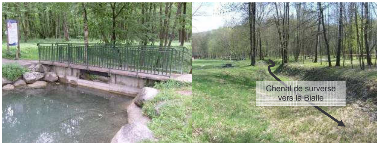
Figure 12 : Ouvrage de régulation de l'exutoire du lac et chenal de surverse (source : photo CIDEE)
