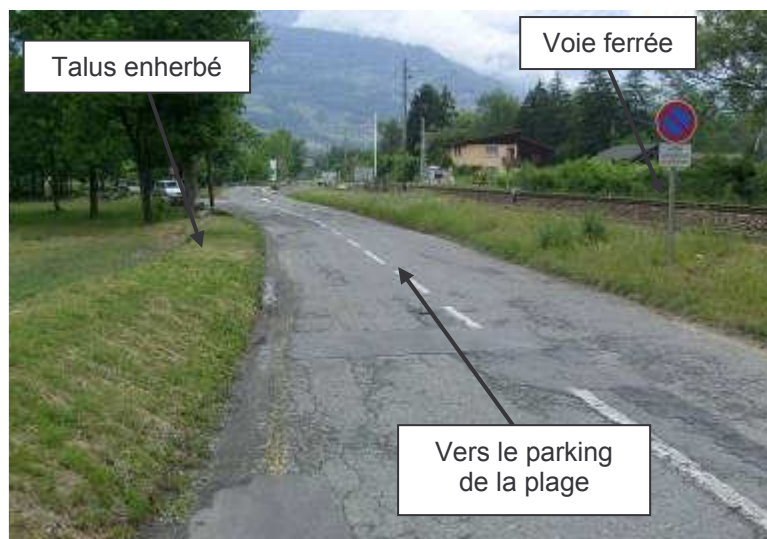
Figure 32 : Voie d'accès au parking de la plage
