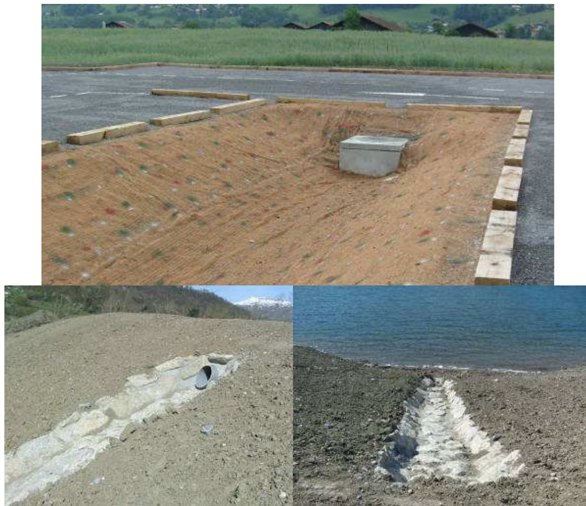
Figure 22 : Trop-plein et rampe en enrochements de déversoir, parking des Granges (source : photo CIDEE)
