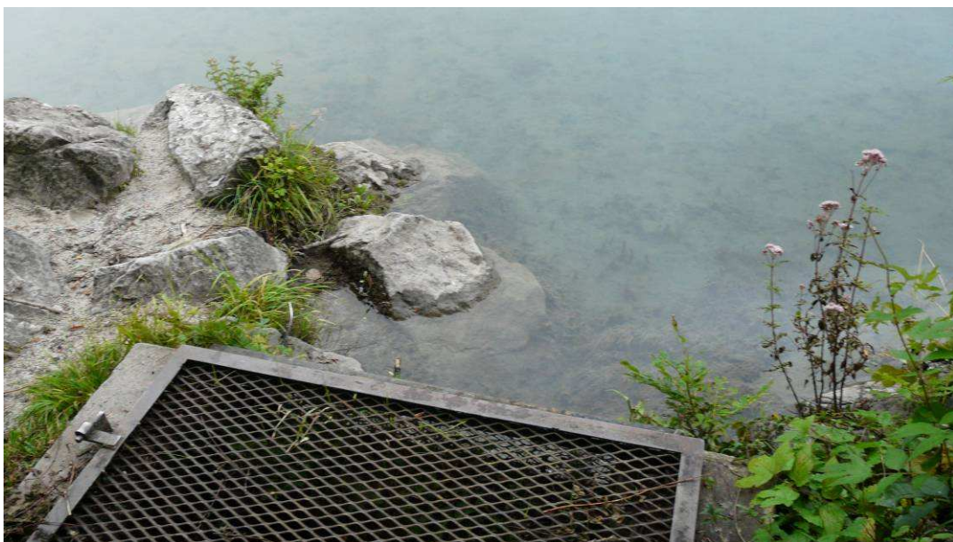
Figure 19: Ouvrage de surverse du lac de Thyez (Source : RPT, Juillet 2011)
