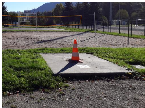
Figure 23 : Douche mise en place pour la saison balnéaire
