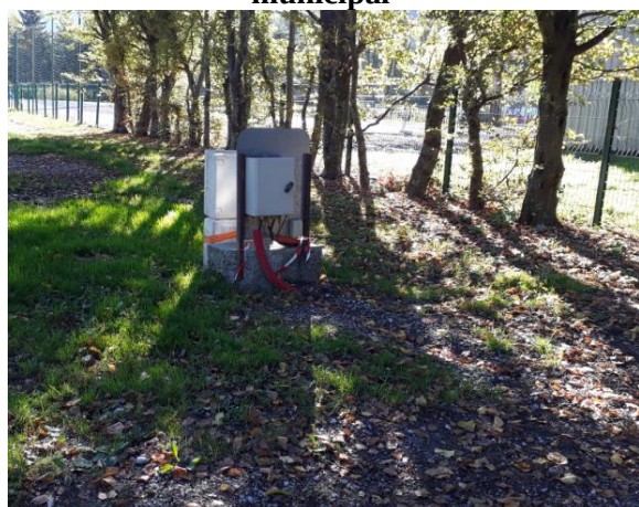
Figure 32 : Raccordement électrique du poste de secours
