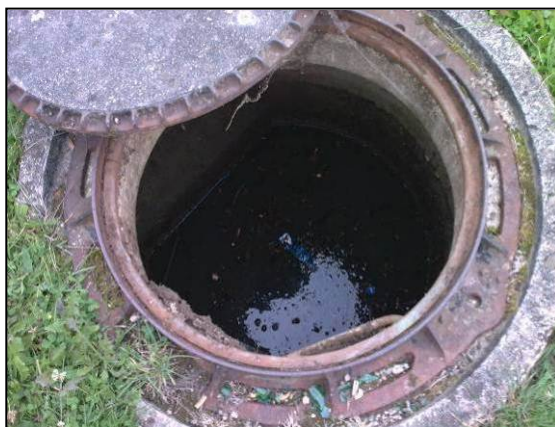
Photo 18 : Regard pluvial en charge le 18/08/2011
