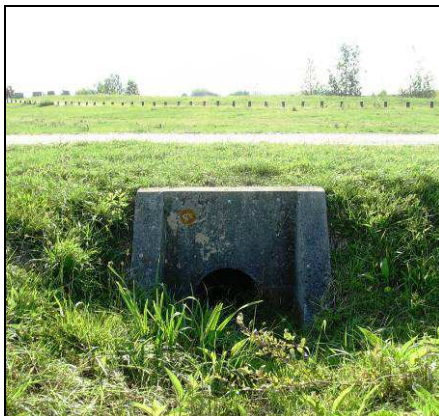
Photo 18 : Buses à l'est du plan d'eau débouchent sur un bassin d'infiltration enherbé
