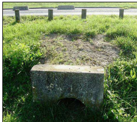
Photo 18 : Buses à l'est du plan d'eau débouchent sur un bassin d'infiltration enherbé
