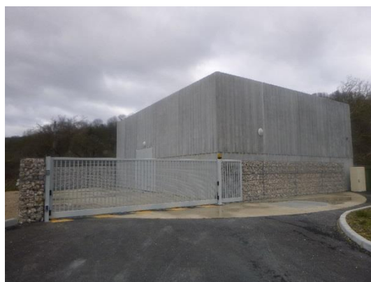
Bassin de rétention
